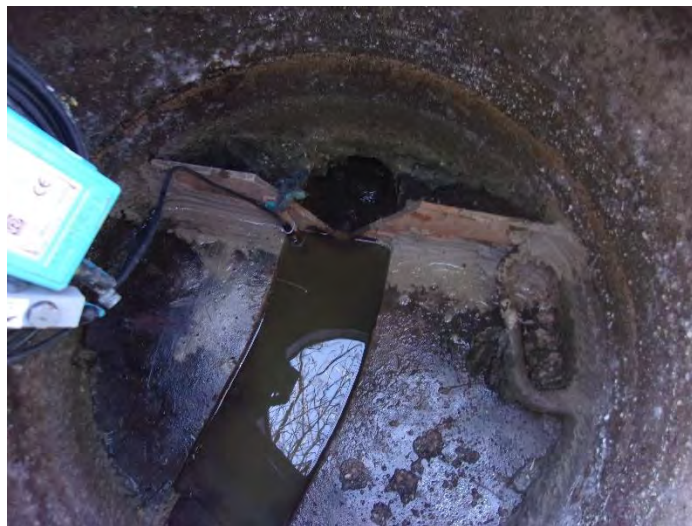
Figure 13 : Photographie du regard 38
